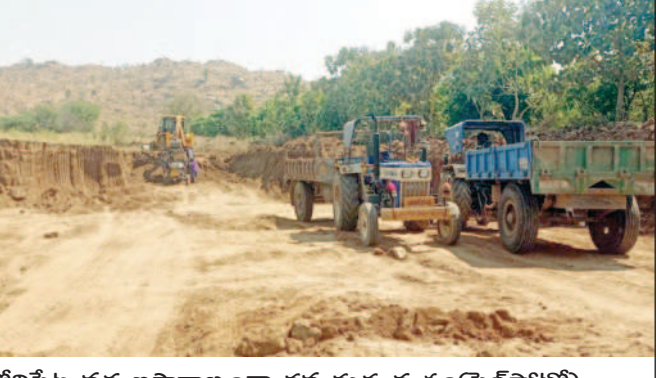
గోనపేట వద్ద ఇష్టారాజ్యంగా తవ్వకం (పైలెట్ ఫోటో)
